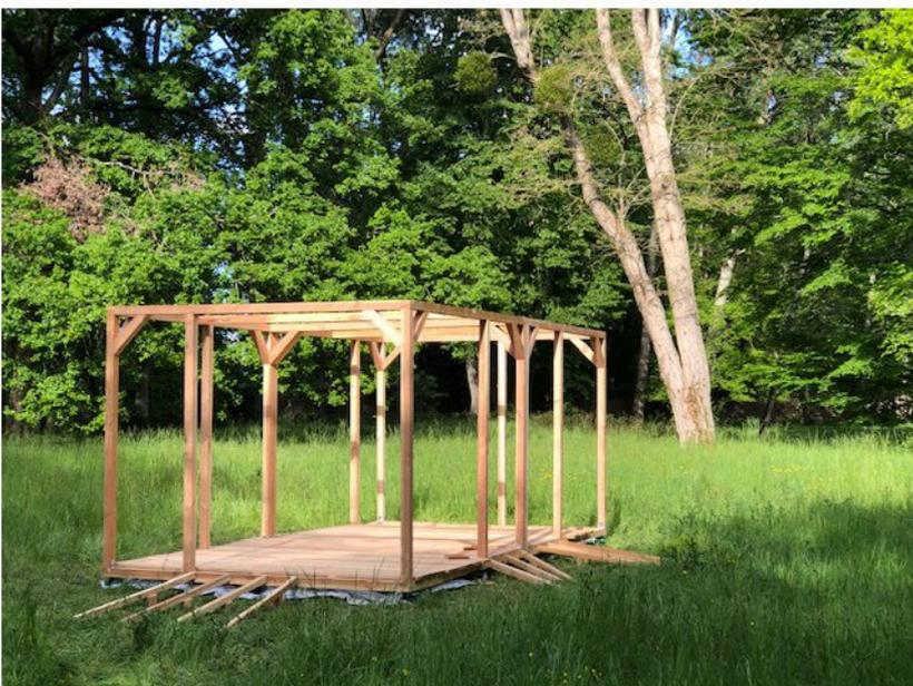
Exemple de Structure avec ossature identique en 80x80mm, 50x50mm et 35x35mm, posée sur plots lambourde
