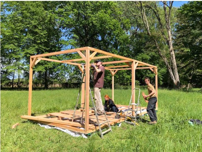
Exemple de montage de structure sur plots lambourde sans fixations au sol
